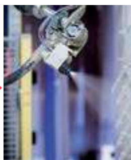
Application du traitement et de la protection
